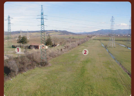
L'argine di Separazione divide il bacino dell'Arno (1) da quello del Tevere (2) The Separation Embankment divides the basin of the Arno (1) and the Tevere (2)
