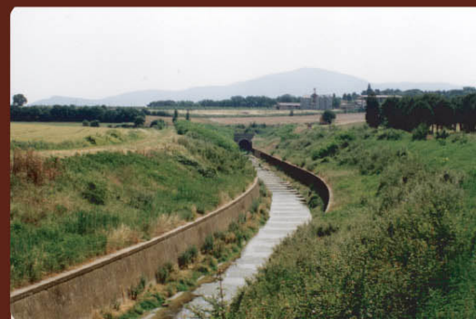
Muri di sponda all'uscita della galleria di Brolio Brolio Tunnel exit with retention walls
