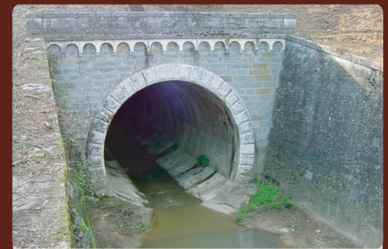
La bocca di ingresso della galleria di Brolio oggi Current status of the Brolio Tunnel entrance
