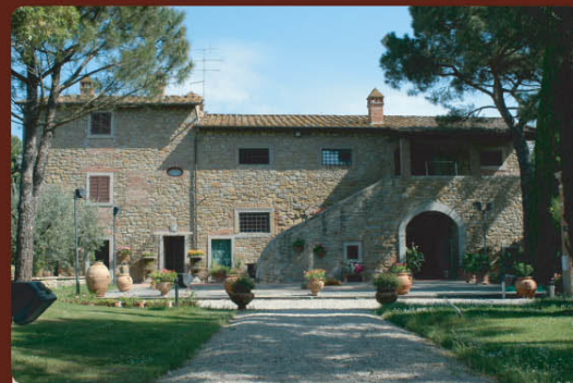
Il Magazzino del Grano nello stato attuale The current status of the Granery
