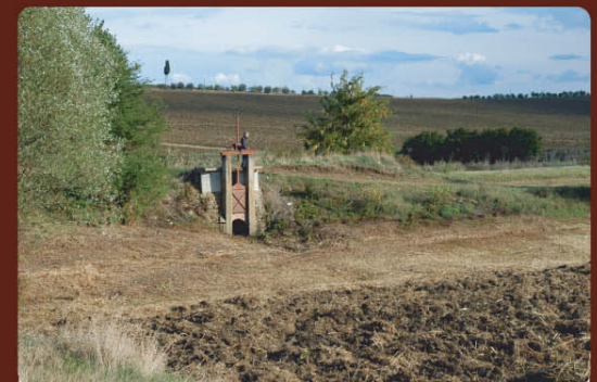
Lo scarico di fondo della colmata di Brolio
