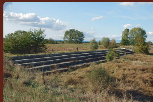
Lo sfioratore di superficie della Colmata di Brolio
