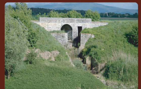
Immissione del Rio Grosso (1) con traverse a paramento verticale e ponte a servizio della strada "alzaia" posta sulla sommità arginale Hand-built masonry weir-inflow at the Rio Grosso (1) with transverse vertical fall and road-way bridge at the embankment summit
