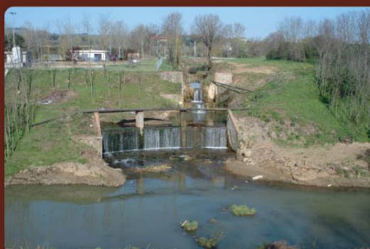
Immissione del Rio Grosso (1) con traverse a paramento verticale e ponte a servizio della strada "alzaia" posta sulla sommità arginale Hand-built masonry weir-inflow with transverse vertical fall at the Lota and Marangone torrents
