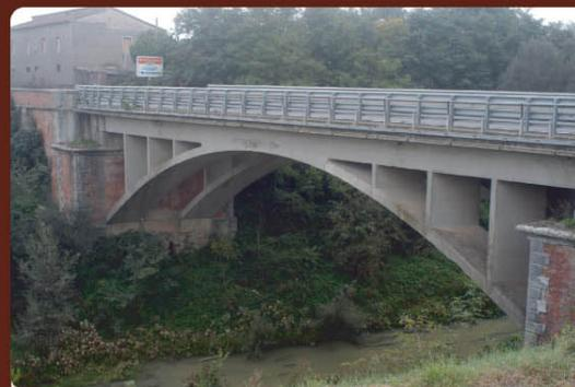
Ponti d'Arezzo ricostruito a metà del XX secolo con impalcato in cemento armato sulle pile del 1890-1910
